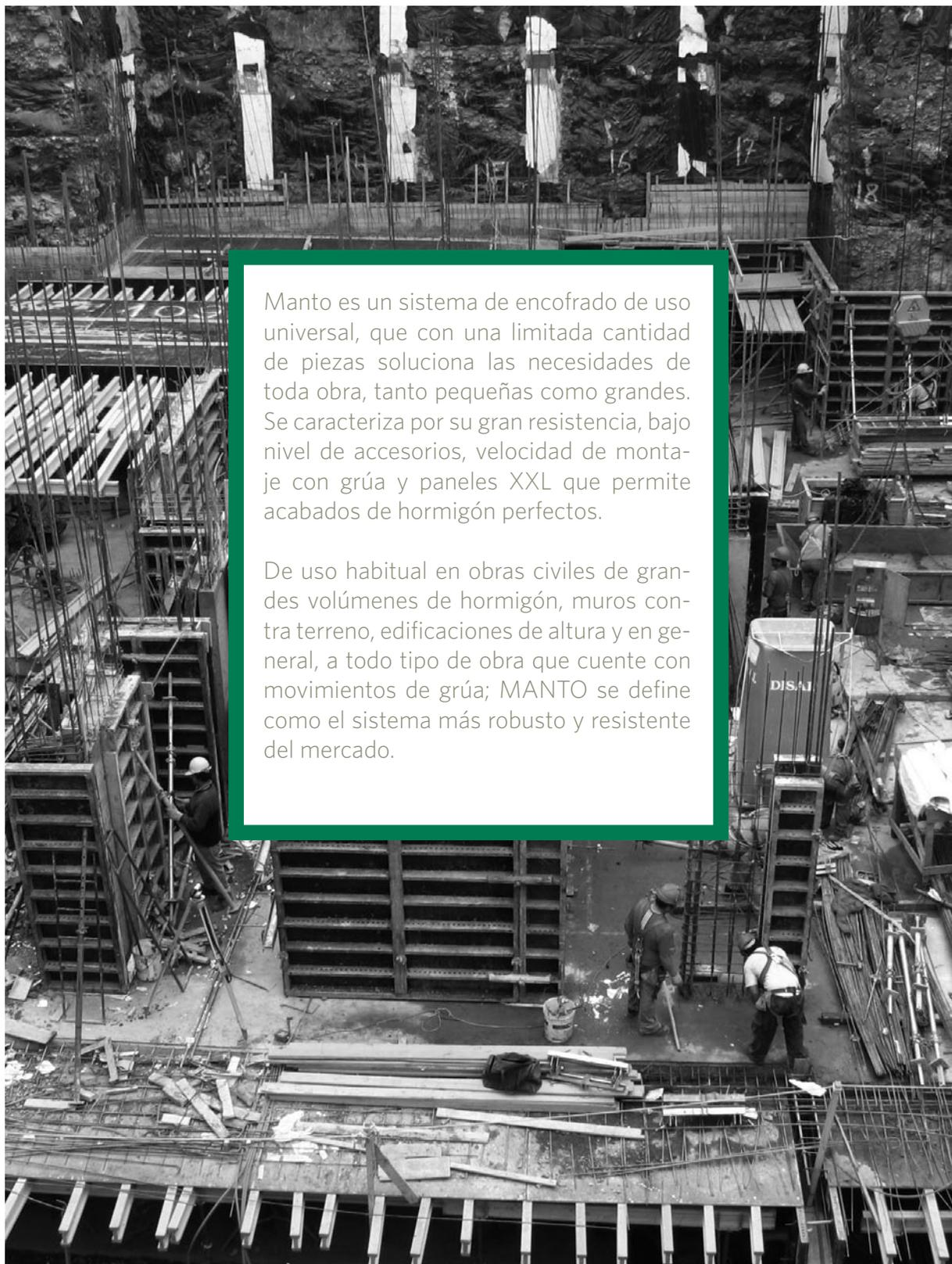
Manto es un sistema de encofrado de uso universal, que con una limitada cantidad de piezas soluciona las necesidades de toda obra, tanto pequeñas como grandes. Se caracteriza por su gran resistencia, bajo nivel de accesorios, velocidad de montaje con grúa y paneles XXL que permite acabados de hormigón perfectos.
