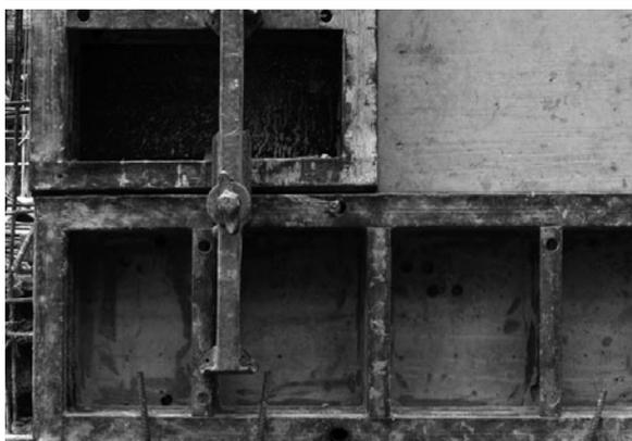
El encofrado Manto es un sistema de paneles pesados fabricados con bastidores de acero y equipados con un perfil de acero galvanizado de 14cm de alto que cubre todo su perímetro. El interior de este perfil permite una fijación adecuada y resistente de todos los elementos de unión utilizados por Soinsa para este sistema.
